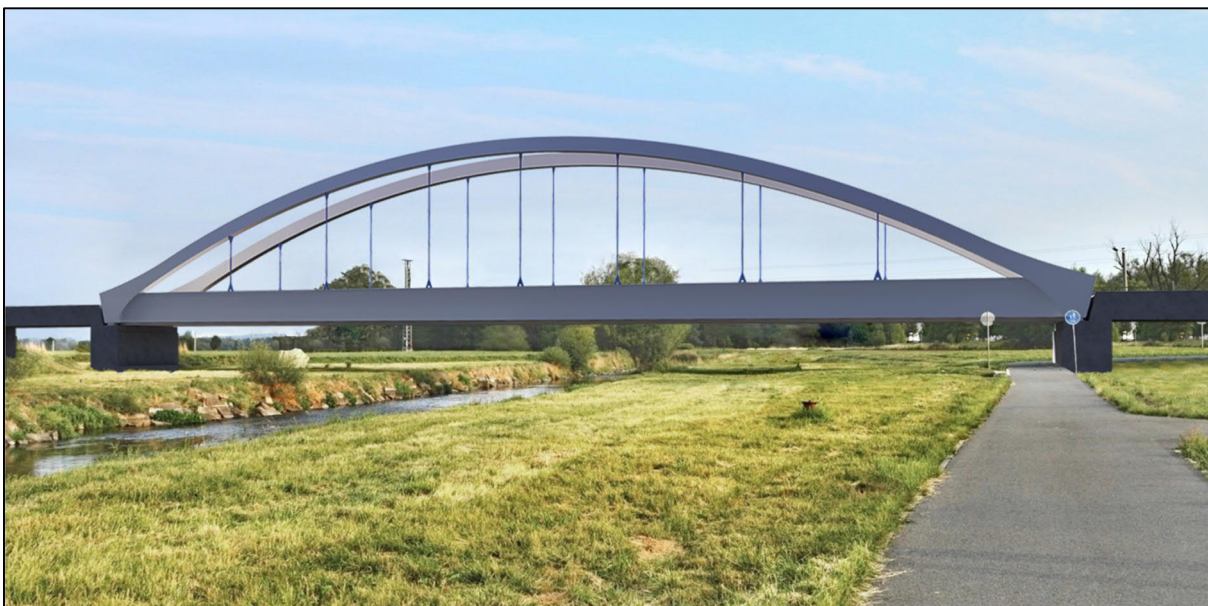
Obr. 3: Vizualizace nového mostního objektu, konstrukce mostu přes Opavu tvořena Langerovým trámem
